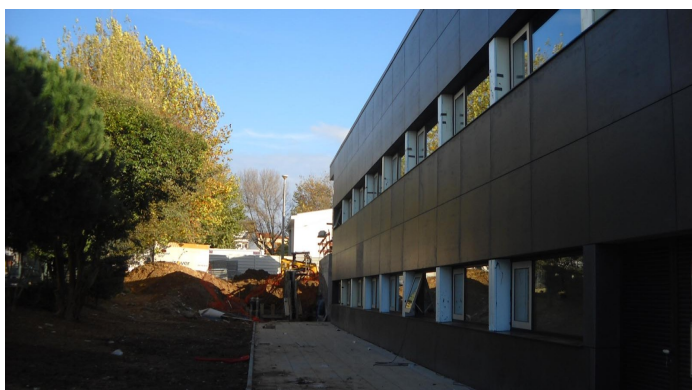
Fachada lado norte.
