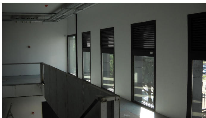
Corredor e escadas, lado poente.
