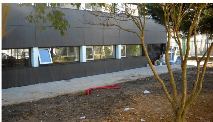
Fachada lado norte.
